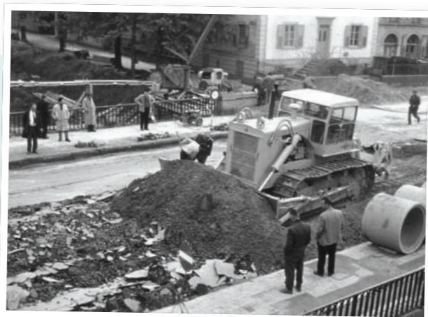
Réfection des rues Haldimand et Cordey en 1961-1962 : pont sur le Canal oriental.
