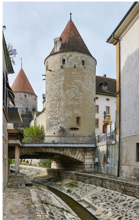
état avant-travaux par Remy Gindroz
