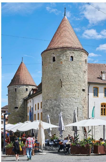
19 . Tour de la Place [A] 2023 avant travaux (R. Gindroz)
