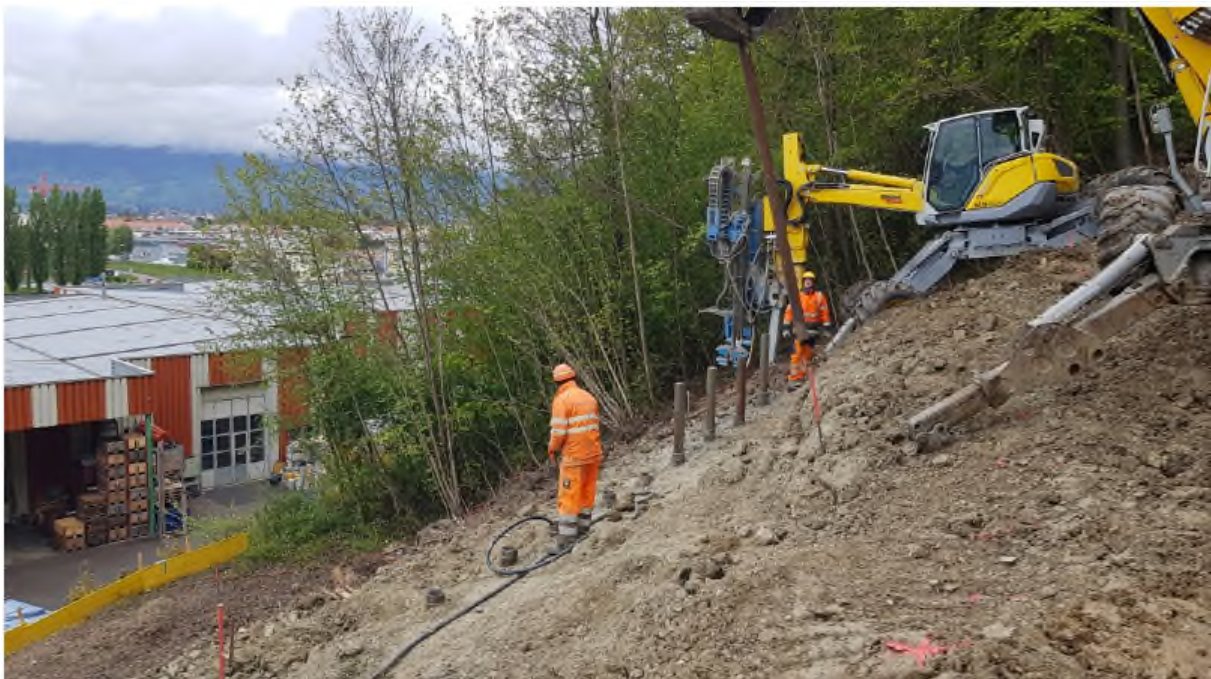
Figure 2 : Travaux de sécurisation. Plus de 92 micropieux ont été enfichés dans le sol.
