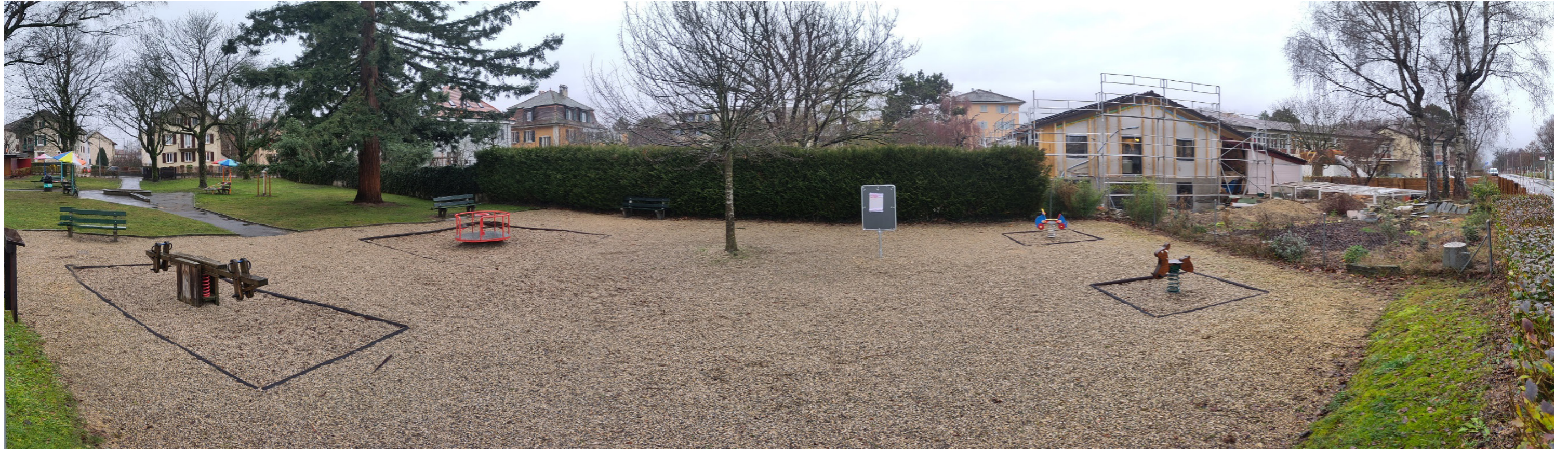
L'état actuel de la place devient préoccupant
